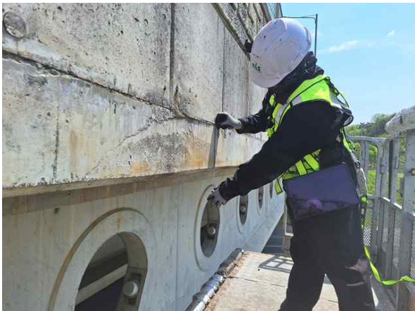
고소작업차를 이용한 부재치수 현장측정
