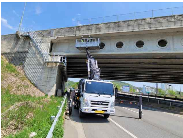
고소작업차를 이용한 근접조사
