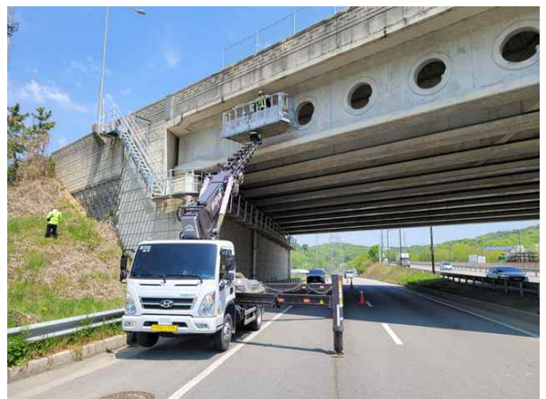
고소작업차를 이용한 근접조사
